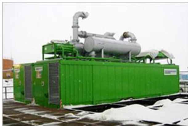
Рисунок 2.3 – Приклад встановлення міні-ТЕЦ на даху багатоповерхового будинку
